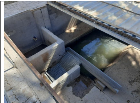
Photo 3-15 Effluent sump
