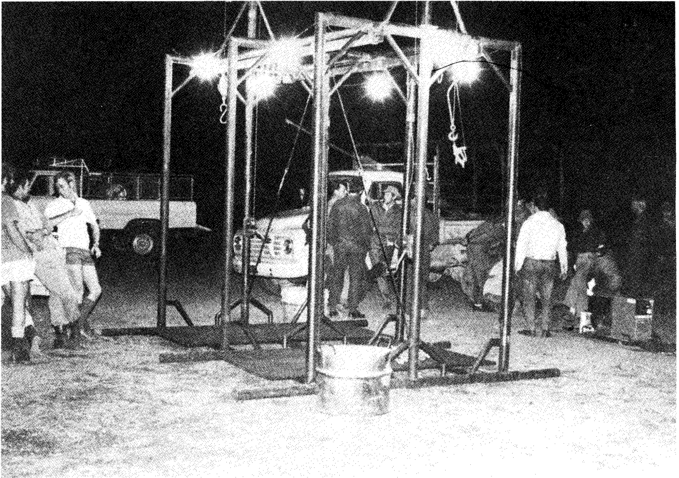
'n Veldslagpale met elektriese ligte en die skietspanpersoneel. Die ligte word deur die sweismasjien verskaf. Breke is iets alledaags en sweiswerk noodsaaklik.
