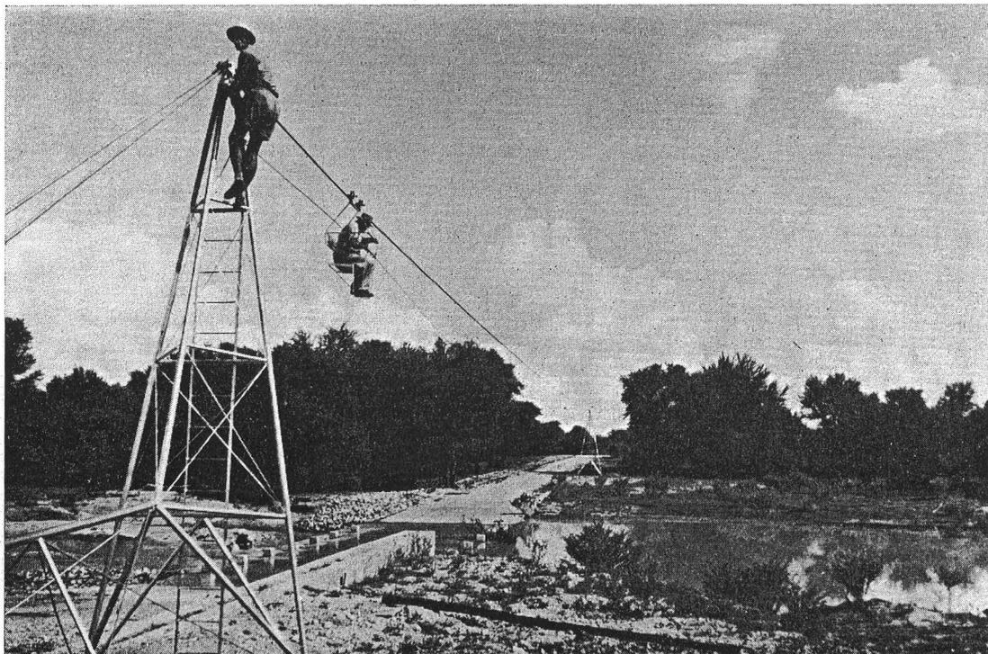
Seilbahn zur Messung der Wassergeschwindigkeit bei den verschiedenen Fluthöhen an der Pegelstelle im Omuramba Omatako auf Farm Ousema, Februar 1962. Im Korb Herr H. W. Stengel, auf dem Turm Herr W. F. W. Holch, der Erbauer der Anlage. — Foto Dr. O. Wipplinger
