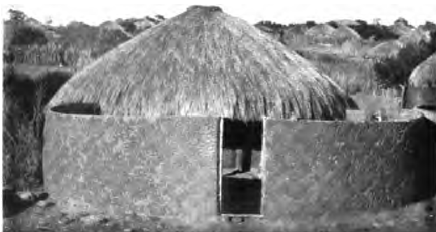
Hütte im oberen Kanya. Okt. 1904.
