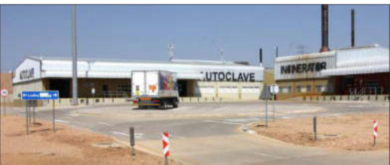
Die neue Anlage der Stadt Windhoek: links der Autoklav, in dem der Müll zerkleinert und in einem Dampfkessel bei 150 Grad Celsius sterilisiert wird, bevor er auf der städtischen Müllhalde entsorgt wird. Rechts ist der zweikammern-Verbrennungsofen, in dem alles Gefährlich zu Asche verbrannt wird. • FOTO: FRANK STEFFEN
