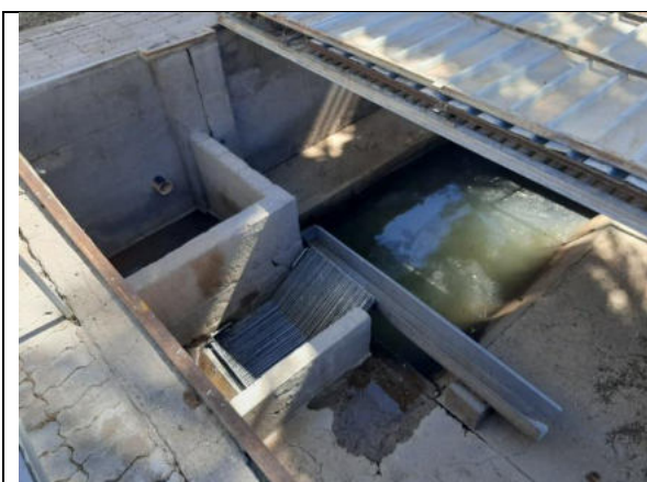
Photo 3-15 Effluent sump
