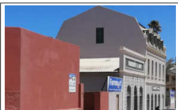
Photo 7-1. Krabbenhöft und Lampe building
