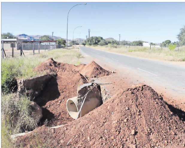
Die reusegat langs Rugbystraat het glo in die reëntyd gevorm waar stormwaterpype onder deur die pad loop. Mnr. Skip Scheepers het die hoop grond aan die regterkant getref, waarna sy motorfiets deur die lug getrek het. FOTO TANJA BAUSE
